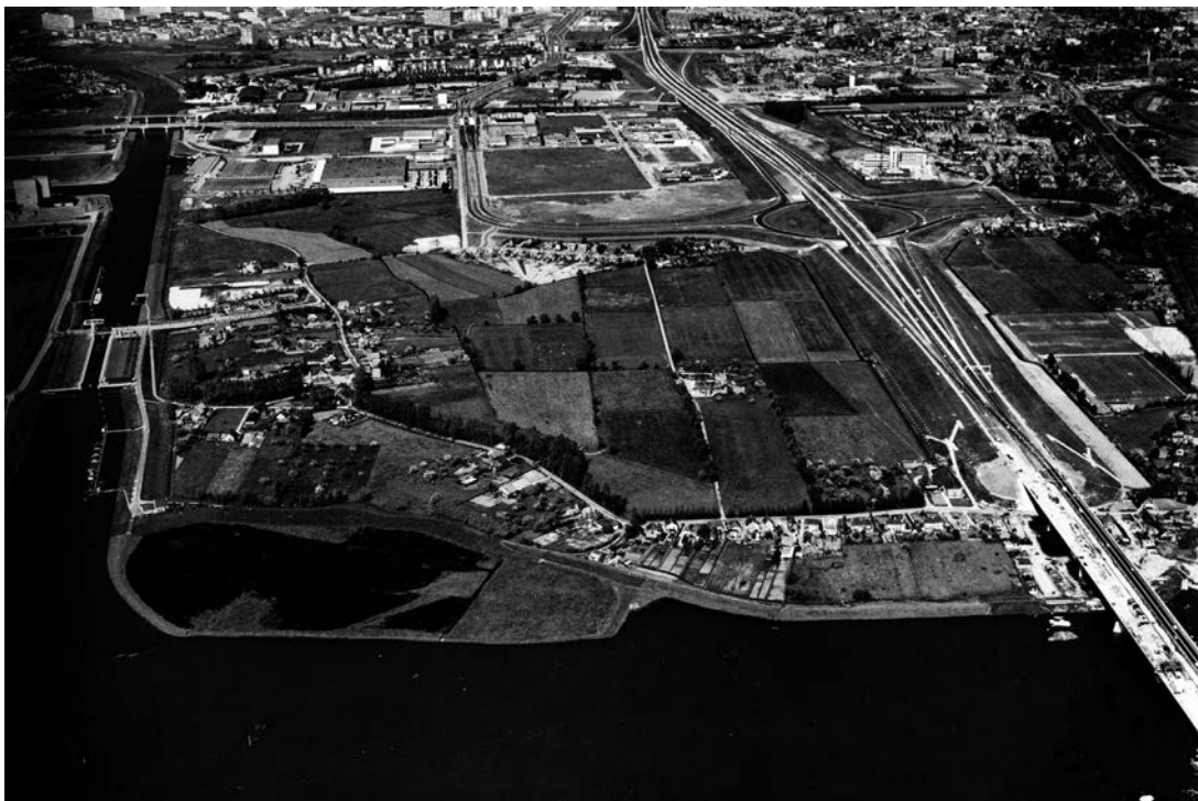
Luchtfoto van Spoolde uit 1970 met links het Zwolle-IJsselkanaal, op de voorgrond de IJssel, rechts de A28 (toen nog RW28) met de nieuwe IJsselbrug in aanbouw. (Bureau Voorlichting Gemeente Zwolle, HCO)
