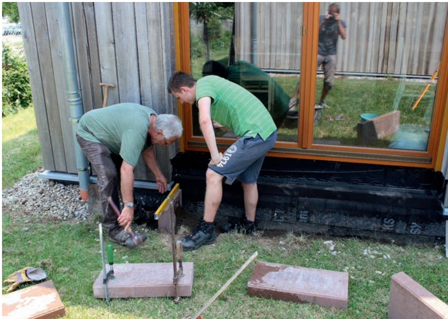
Abb. 2: Arbeitseinsatz am 9. Juni.
