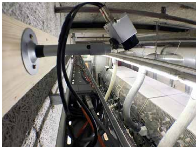
Infrarotkameras von Optris sind an mehreren Stellen der Hobelanlage installiert.
