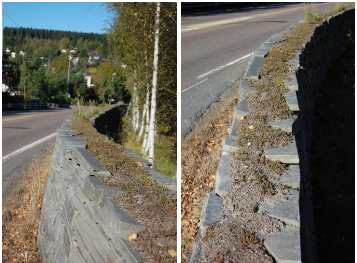
Fig. 68. Sedum acre fungerer fortsatt bra etter 12 år på skifermur langs veg, Hagan Nittedal, september 2010.
