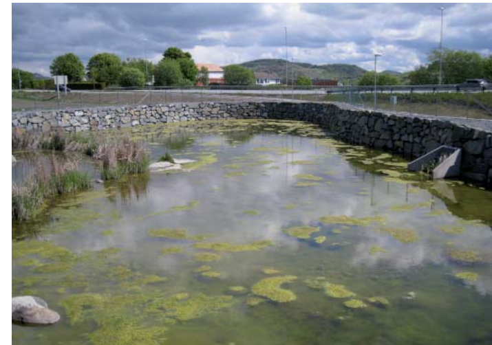
Infiltrasjonsbasseng som fungerer etter hensikten med alger som har dannet seg naturlig og binder seg til seg overfløydige næringsstoffer fra bla. landbruket, og vannplanter som forsinker vanngjennomstrømming til venstre i bildet. Vannstanden er for lav pga. ventilene i kummen er for åpen. Bildet er fra ny rv. 44 ved Folkvord, Sandnes.
