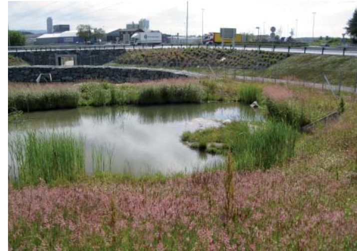
Infiltrasjons-baseng langs rv. 44 ved Ganddal i Sandnes.
