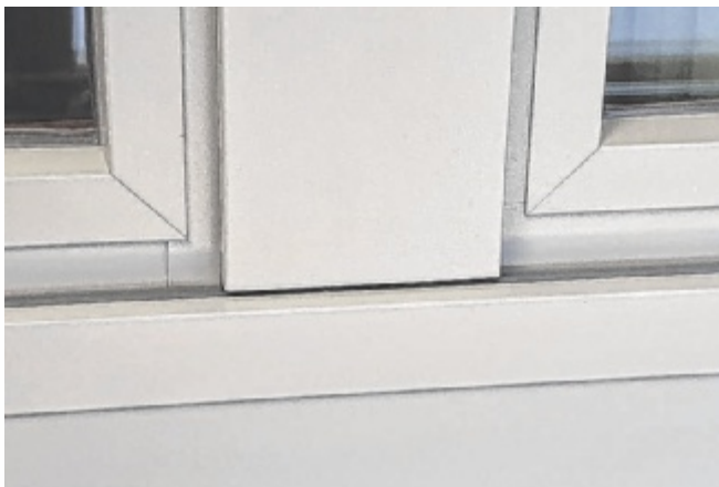
Saniertes Fenster mit KANOVA Aluminiumverkleidung
