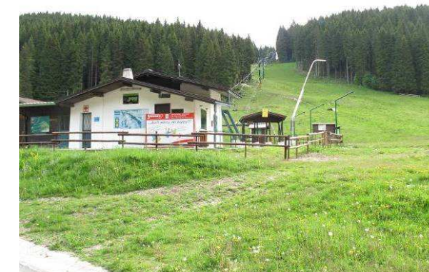
Edifici impianti di risalita
