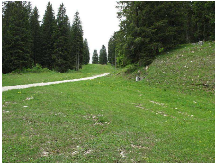
Figura 3-2. Tratto intermedio della pista Krauslava (vista da valle da quota 1.460 m). La pista esistente sarà oggetto di ampliamento
