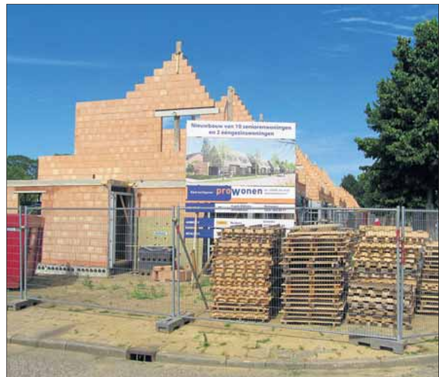
De Steege in aanbouw
