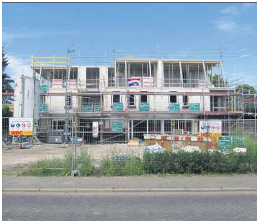
De Zon in aanbouw
