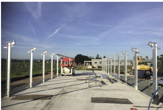
Montage der Stützpfiler für das insektensichere Gewächshaus im Juni 2021
