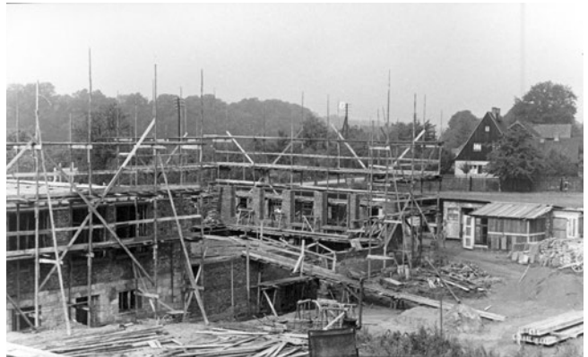
Bauarbeiten am Fachschulgebäude
