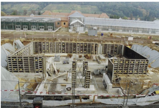
Der Bau des Funktionsgebäudes für den neuen Gewächshauskomplex hat begonnen
