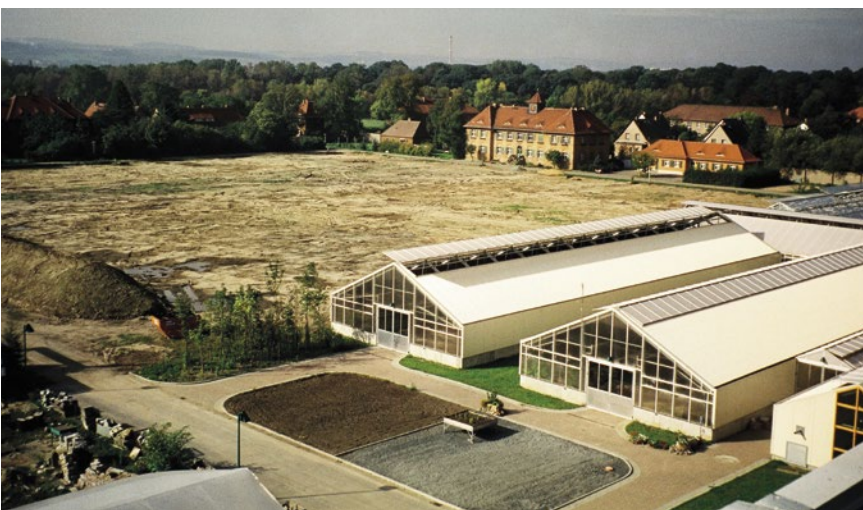
Die fertiggestellten Gewächshäuser und Übungshallen der Überbetrieblichen Ausbildung 1998, dahinter das Baufeld für die Gewächshäuser des Fachbereiches Gartenbau, der Hochschule für Technik und Wirtschaft und des Institutes für Obstzüchtung
