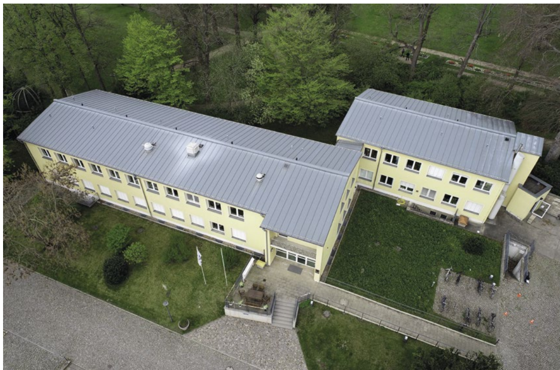
Büro- und Laborgebäude des JKI-Instituts für Züchtungsforschung an Obst in Dresden-Pillnitz im Jahr 2021
