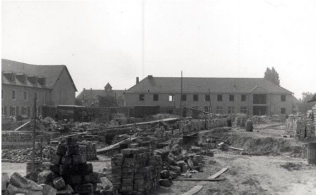
Neubau der Fachschule an der Söbrigener Straße, 1954. Der erste Teil des Wohnheimes (links) und der Rohbau der Mensa stehen bereits
