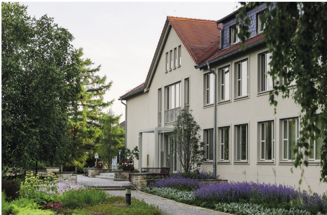
Das Schulgebäude nach der Fassadensanierung 2011
