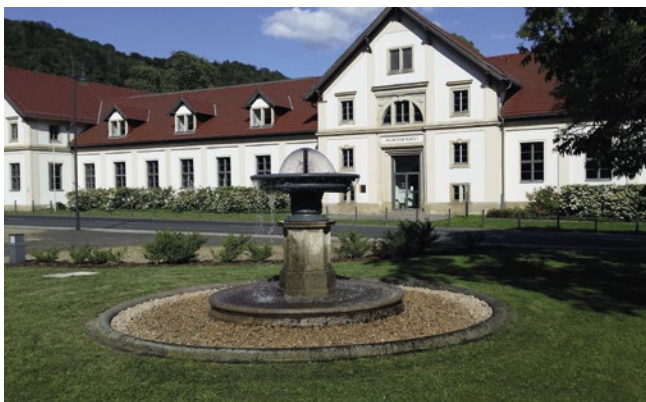
Das Seminargebäude am Pillnitzer Platz, 1998 - 2000 denkmalgerecht saniert
