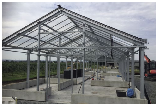
Die Metallkonstruktion des insektensicheren Gewächshauses steht.
