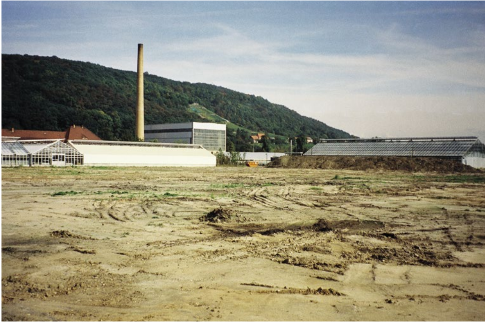
Das Baufeld für die Gewächshäuser des Fachbereiches Gartenbau, der Hochschule für Technik und Wirtschaft und des Institutes für Obstzuchtung. Die Gewächshäuser der Überbetrieblichen Ausbildung stehen bereits.
