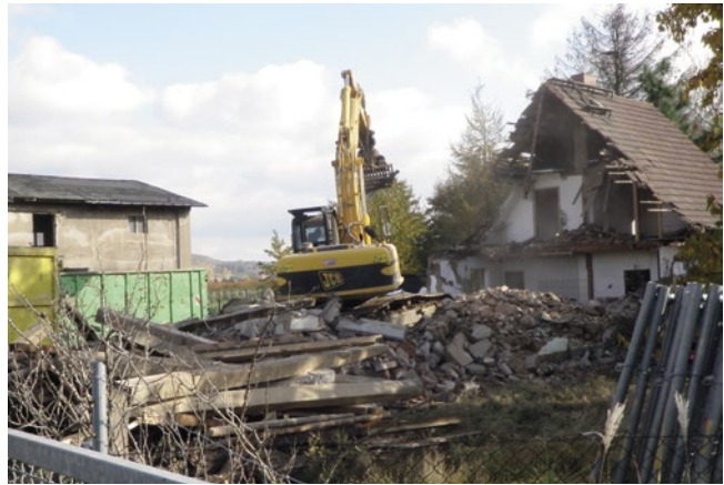
Abriss des Neubauernhauses im Versuchsfeld am 30. September 2009, um Platz für den Neubau einer Mehrzweckhalle mit Lagerhaus zu schaffen
