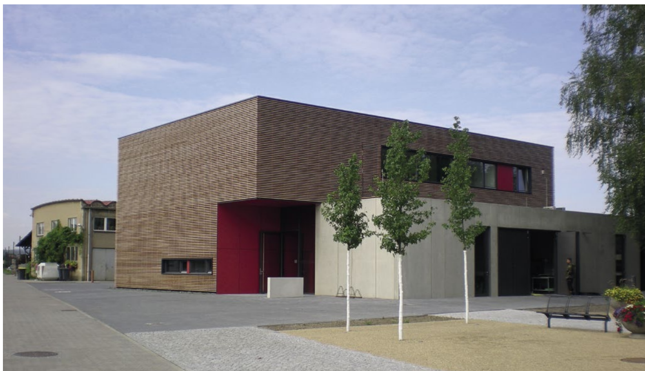
Das neue Labor- und Werkstattgebäude im Versuchsfeld
