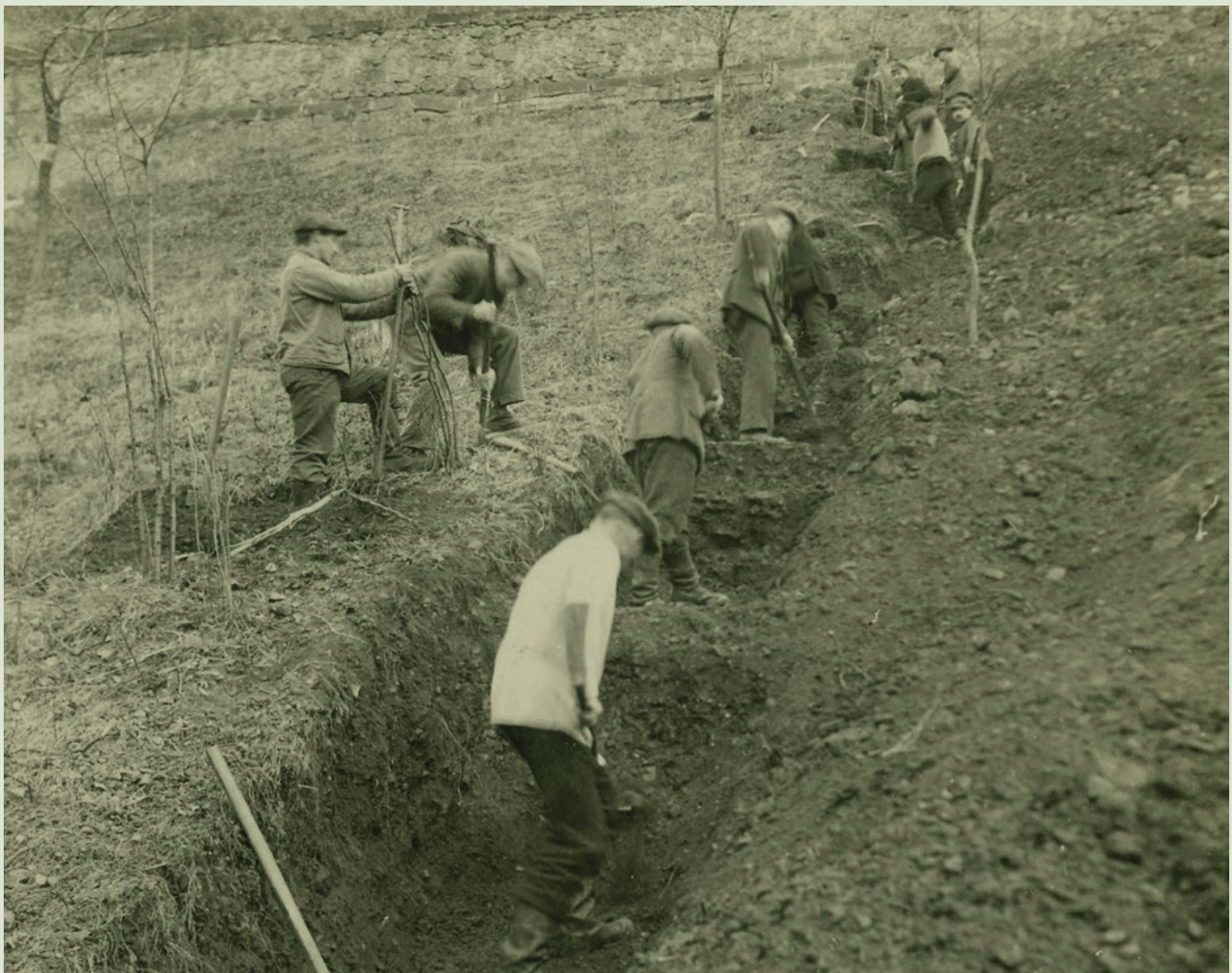
Rigolen mit Sprengstoff und Handarbeit 1924 auf dem Weinbergsgelände zur Vorbereitung der Wiederaufhebung. Die beiden Personen links setzen eine Reihe neuer Sprengpatronen 50 cm vom Grabenrand ein.
