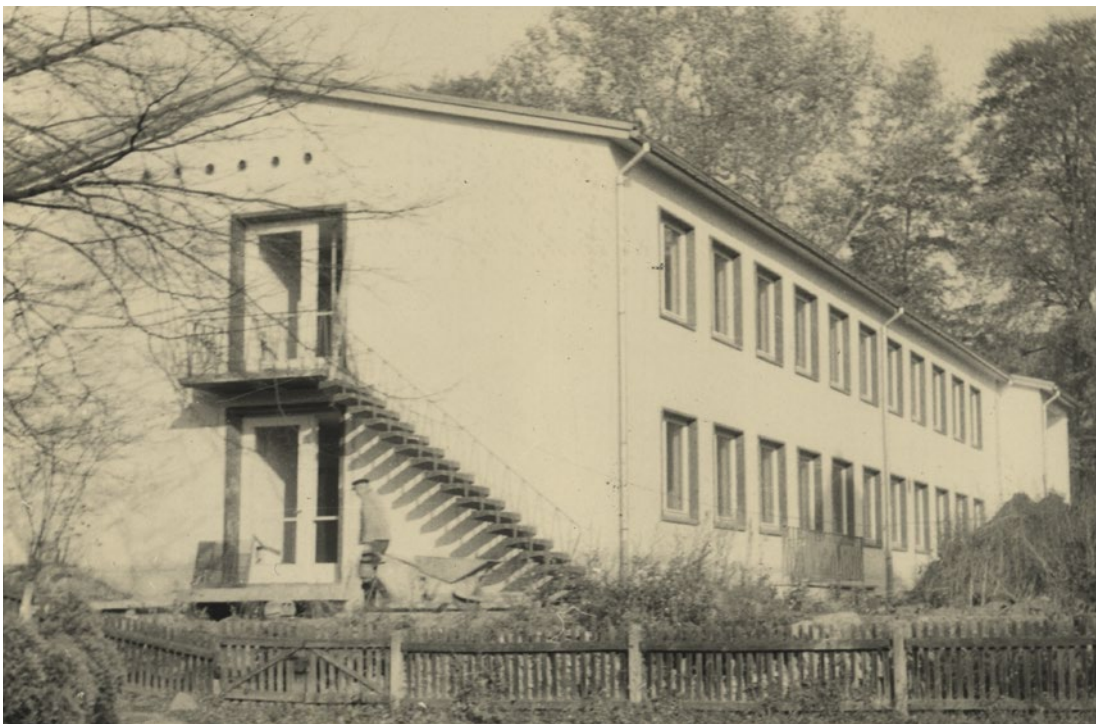
Das neue Physiologiegebäude 1963
