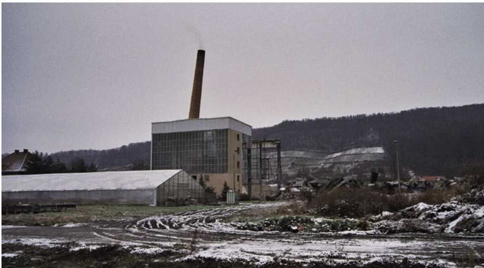
Der Schornstein des Heizhauses wird am 23.12.1998 gesprengt
