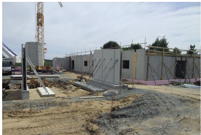
Stand der Bauarbeiten der neuen Mehrzweckhalle mit Lagerhaus am 19. Juli 2011
