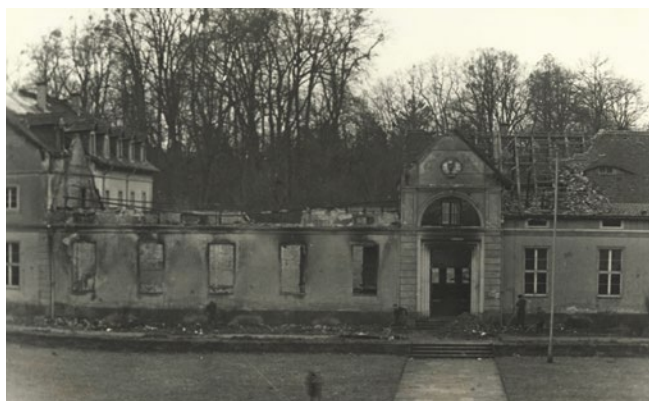
Das zerstörte Aulagebäude nach den Bombenabwürfen vom 2. März 1945
