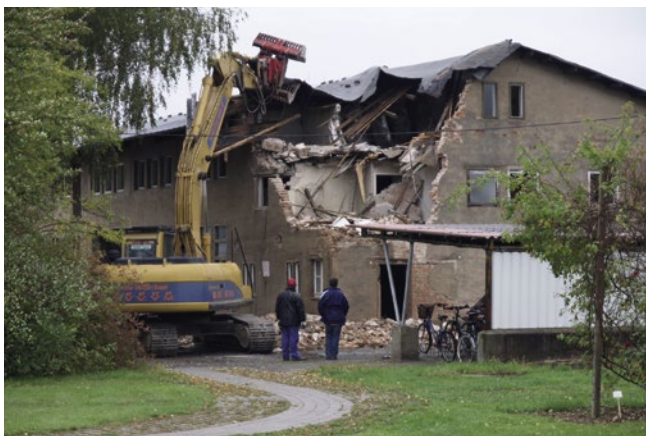
Abriss des Gebäudes 2 im Versuchsfeld 2007
