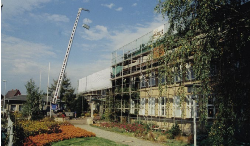
Dachausbau und -neueindeckung an der Fachschule 1997
