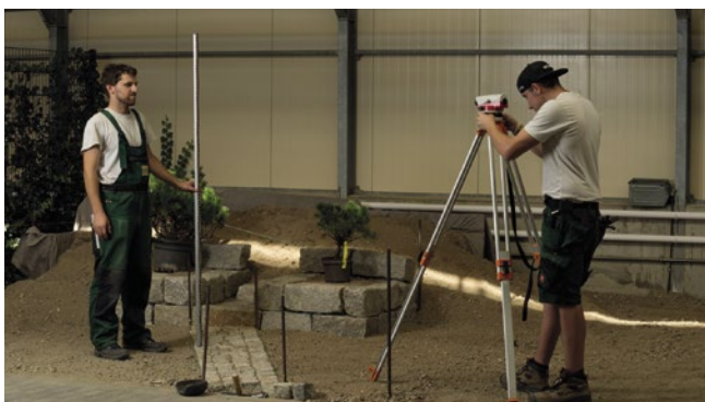
Bau eines Gartendetails in der Übungshalle
