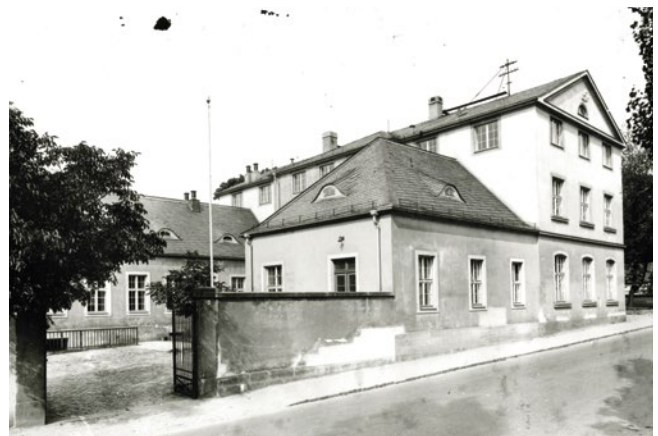
Die Obst- und Gemüseverwertungsanstalt, das ehemalige Hofwaschhaus, um 1926
