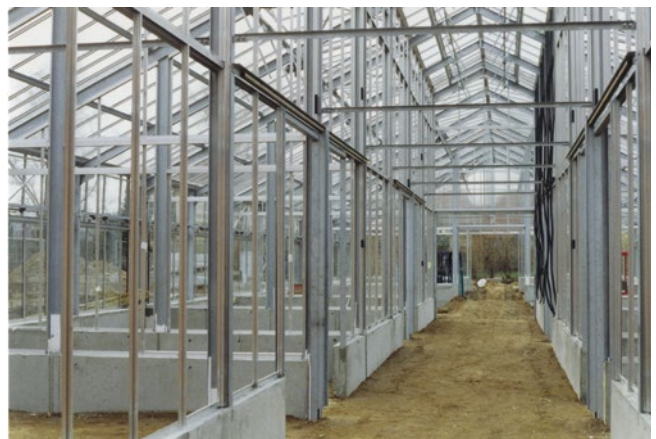
Die Hülle des neuen Gewächshauses steht
