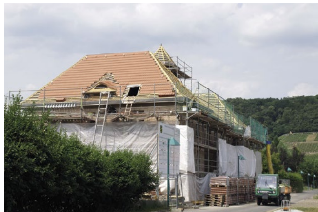
Mitten in den Sanierungsarbeiten – das Gehilfenhaus 2010
