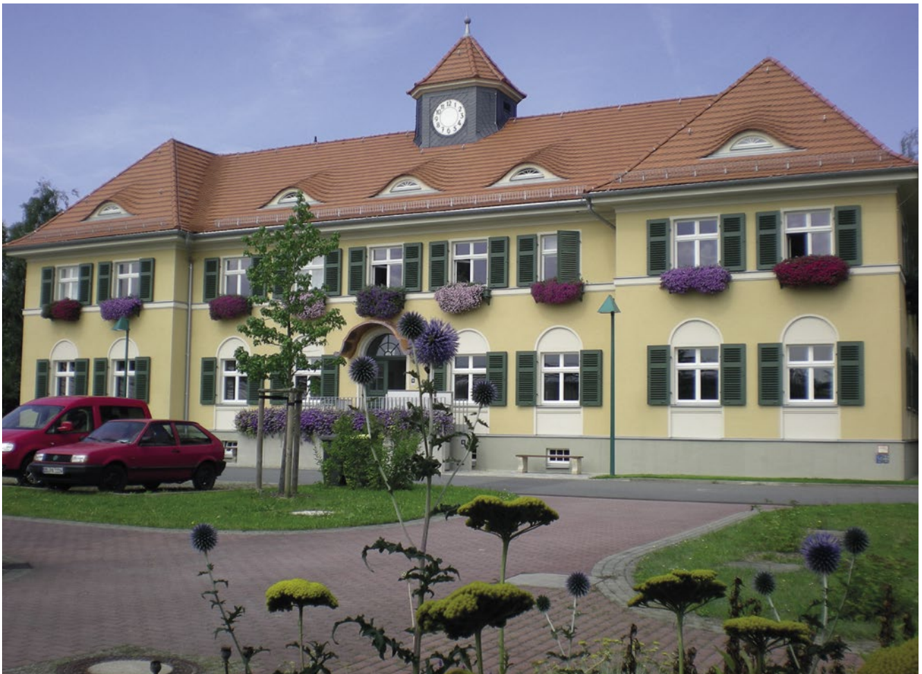
Das sanierte Gehilfenhaus im Blumenschmuck 2011
