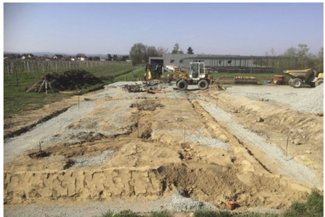
Erste Arbeiten zum Bau des insektensicheren Gewächshauses zur virusfreien Erhaltung von Vorstufenmaterial im April 2021
