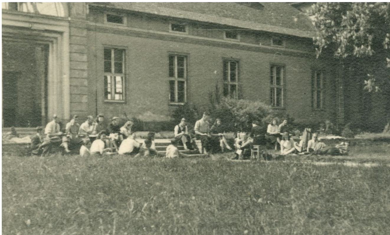
Vorlesung vor dem zerstörten Aulagebäude 1947
