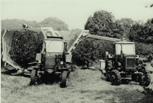
Ernte von Sauerkirschen mit der kontinuierlich arbeitenden Erntemaschine (links) und Übergabe der geernteten Früchte an ein parallel fahrendes Transportfahrzeug (rechts)
