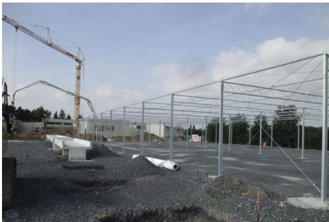
Errichtung der Überdachung für die Erdbeerkastenanlage am 22. August 2011
