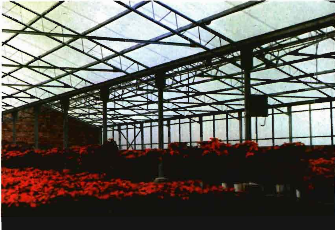
Cubierta realizada en VIVERS "LA VINYA" (Sant Iscle de Vallalta) Placa Celular CRICEL 8 mm. espesor
