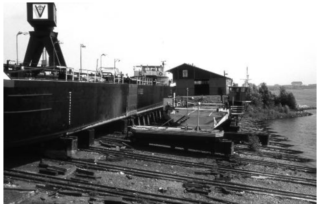
De pont Willem op de helling voor een reparatie.
