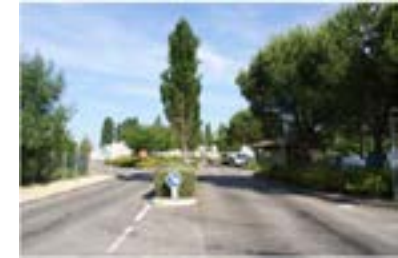
12 – Entrée Sud Peujard nouveau
