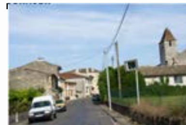
20 – Entrée Ouest St Laurent d'Arce
