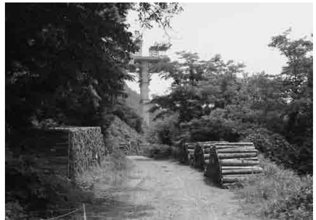
写真：通路両側に積まれた伐採木(土場) 写真右側が吾妻川、奥は「湖面2号橋」 2009年6月26日撮影
