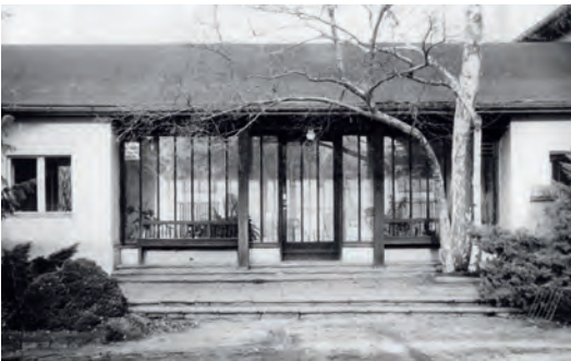
„Glashalle“, ehemaliger Empfangsraum für Privatkunden
