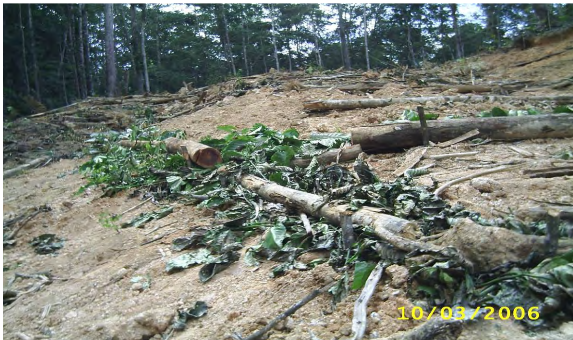
Figure 7: Barrière anti-érosion sur zone escarpée.
