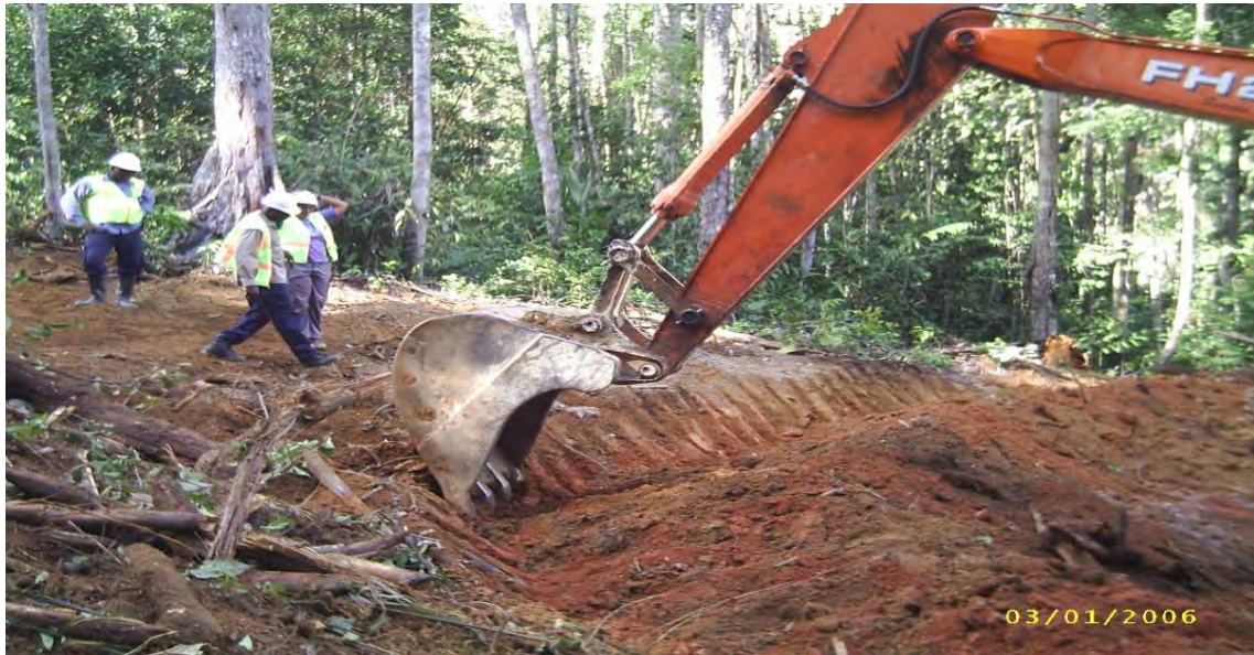
Figure 4: Zone qui a été talutée
