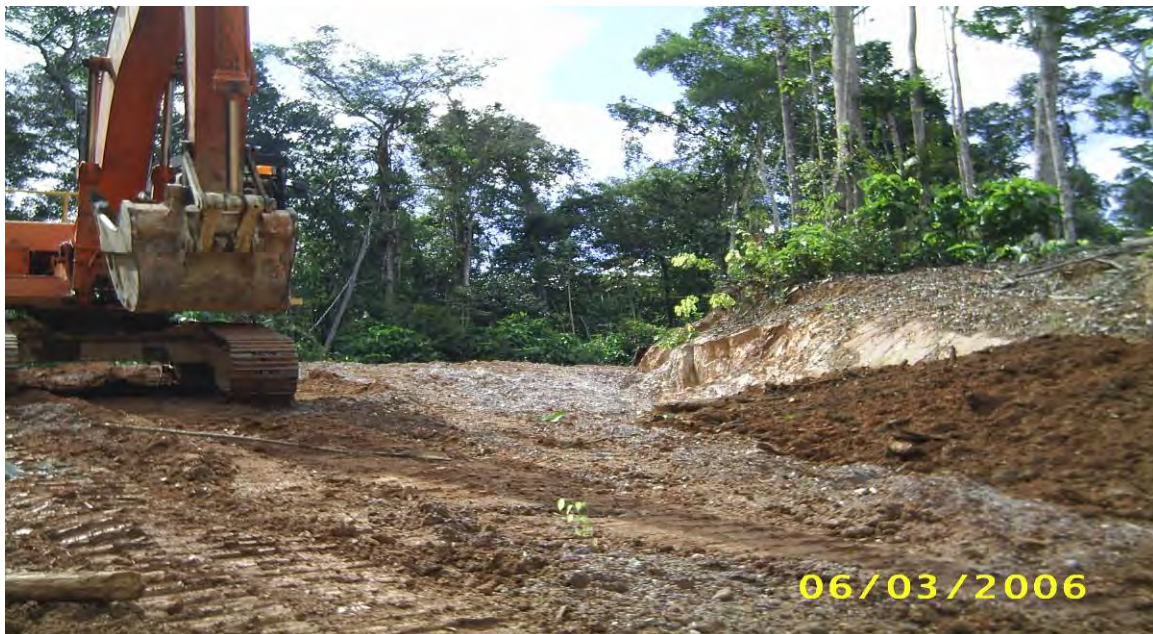
Figure 5: Zone escarpée qui a été remblayée
