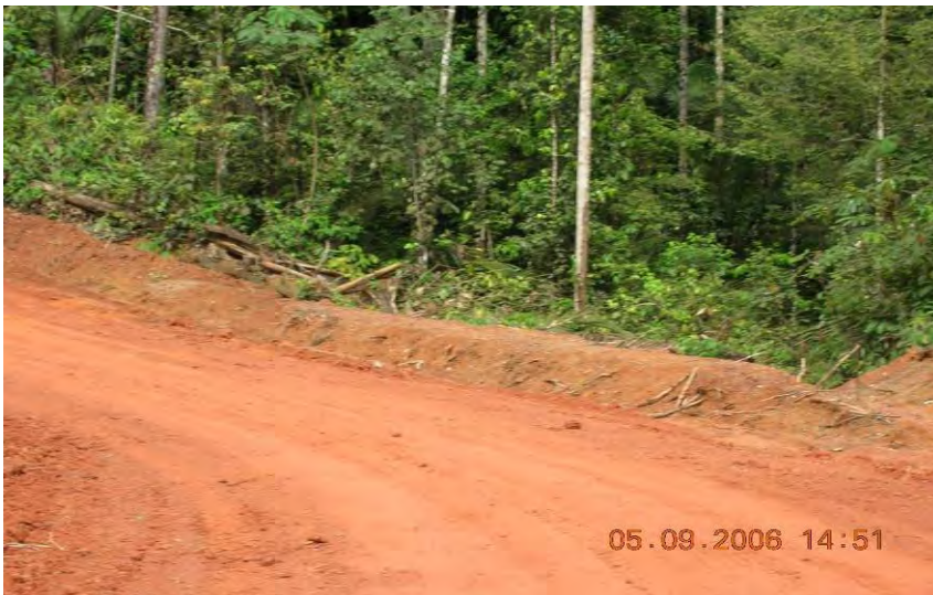
Figure 2: Méthode correcte montrant la végétation et la couche arable mélangées au sol et employées comme berme.
