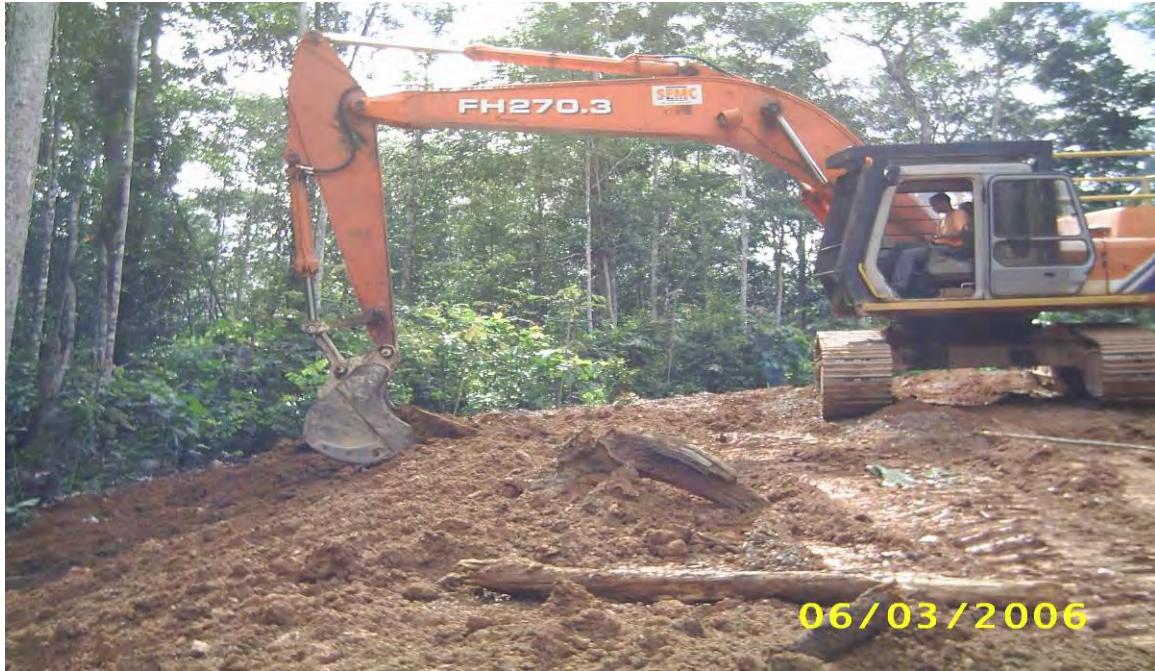
Figure 3: Zone qui a été rainurée.
