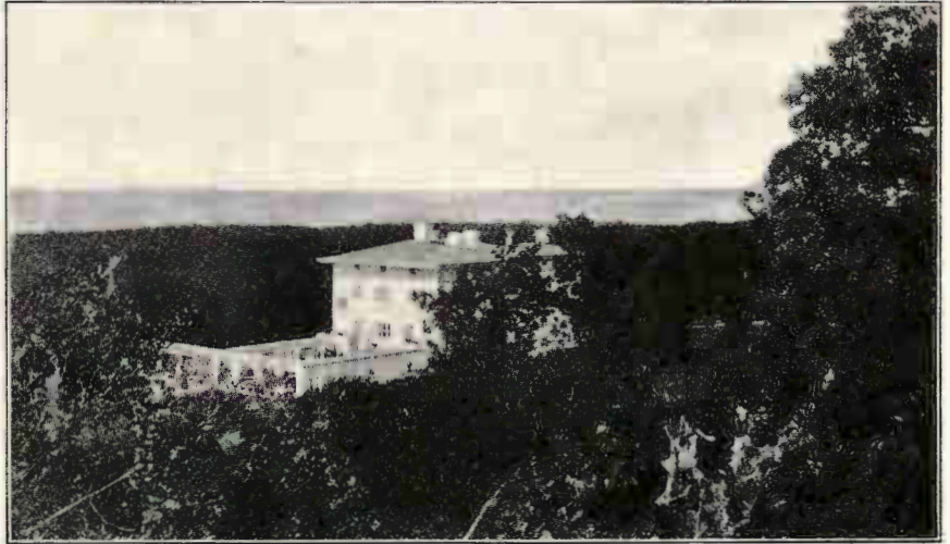
Fig. 13. Solliden sett uppifrån alvarsidan.
