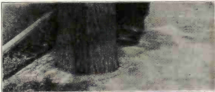
Fig. 4. Ek, vars fotpall försetts med 90 cm hög uppfyllning av sten och cement. Stockholm, Sturevägen.
