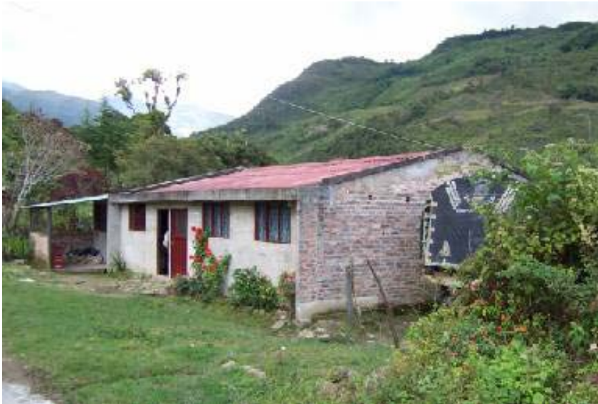
Foto No. 34 - Casa en ladrillo Sector Sismosá
