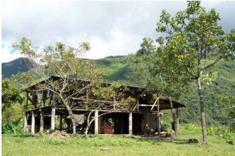
Foto No. 32 - Casa de dos pisos en madera Sector Burici
