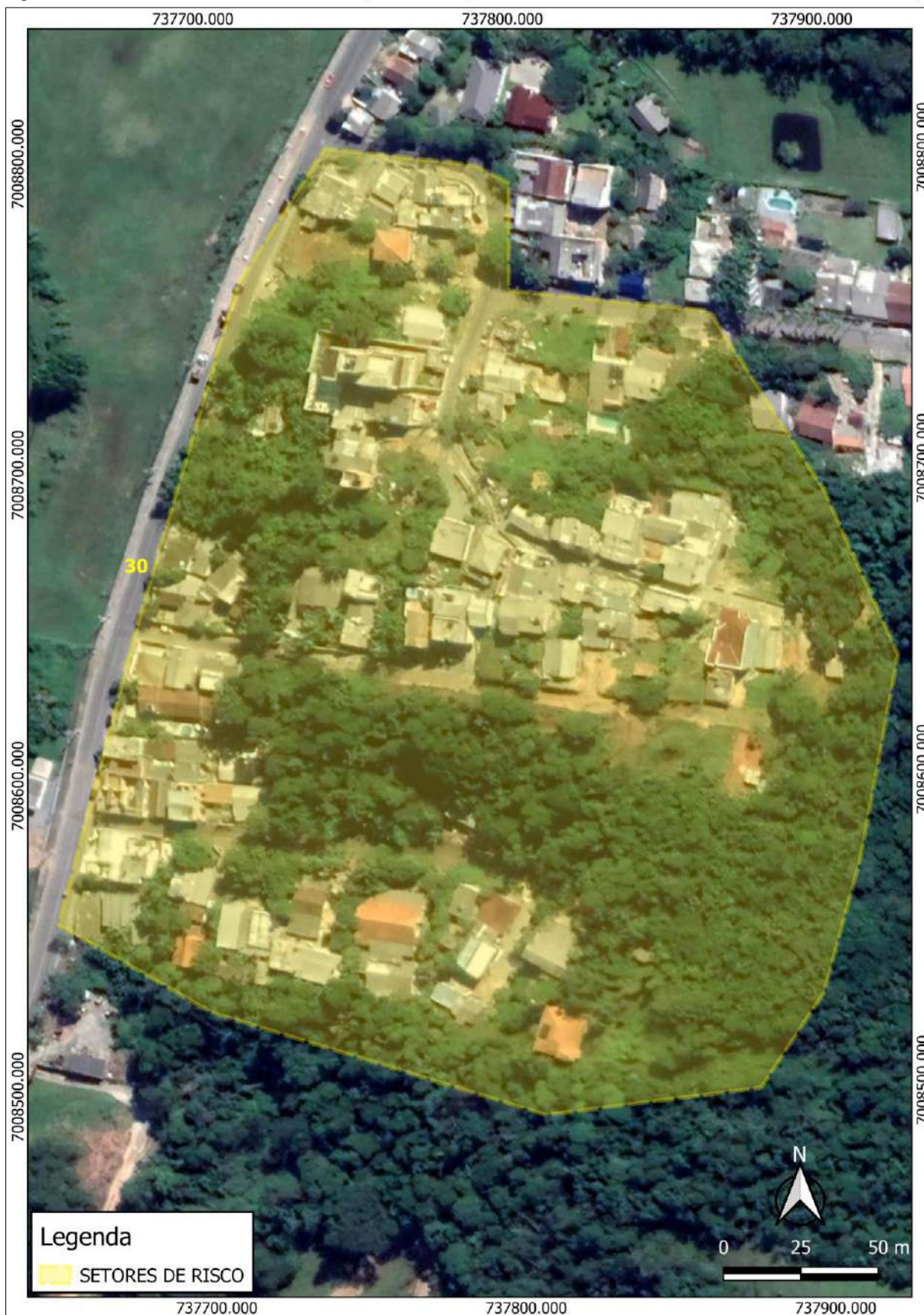
Figura 55 - Movimentos de Massa: Setor de Risco 30.
