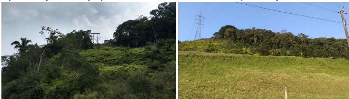
Figura 222 Supressão de vegetação em faixa de domínio de linha de distribuição de energia.
