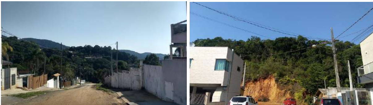
Figura 229 – Exemplo de ocupação em encosta na Rua Ilhas Virgens.
