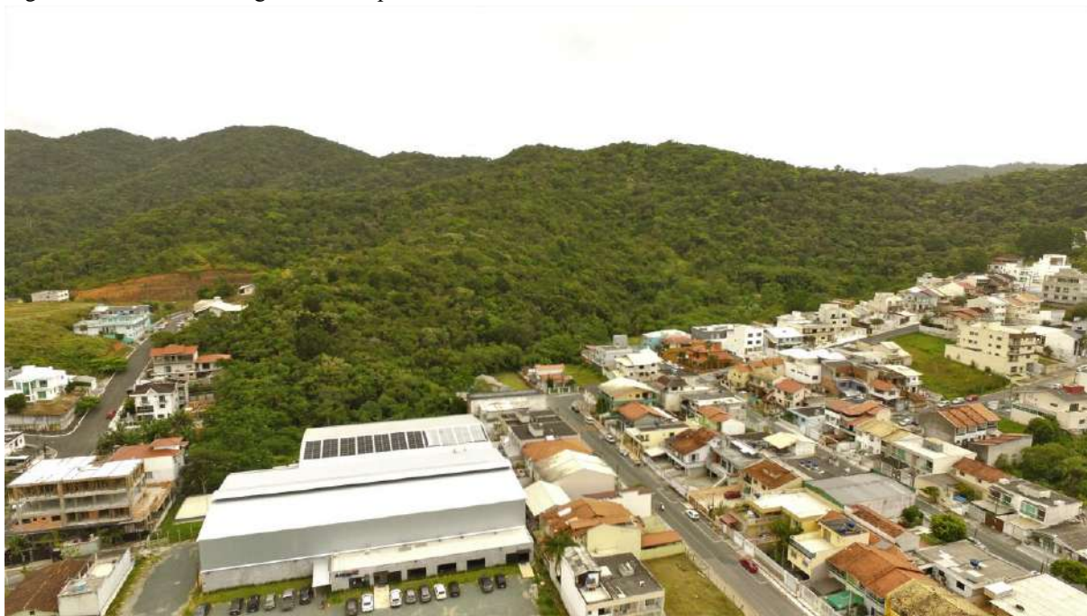
Figura 135 - Vista do “fragmento 1” a partir da Avenida dos Tucanos.
