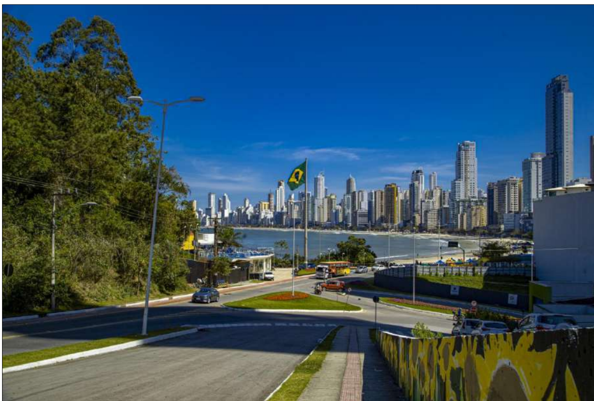
Figura 85 - Vista da orla a partir da Estrada da Rainha.
