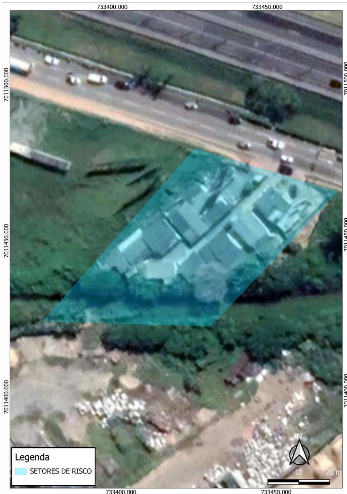
Figura 61 - Risco Hidrológico: Setor de Risco 04.
