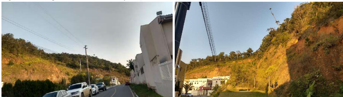
Figura 232 – Expansão urbana e formação de taludes e áreas de risco na Rua Rouxinol.
