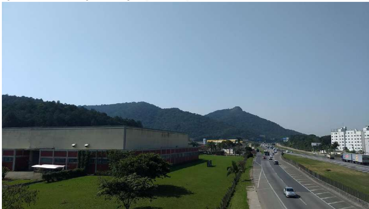
Figura 134 - Vista do “fragmento 1” a partir da BR 101, com o “Morro do Gavião” ao fundo.
