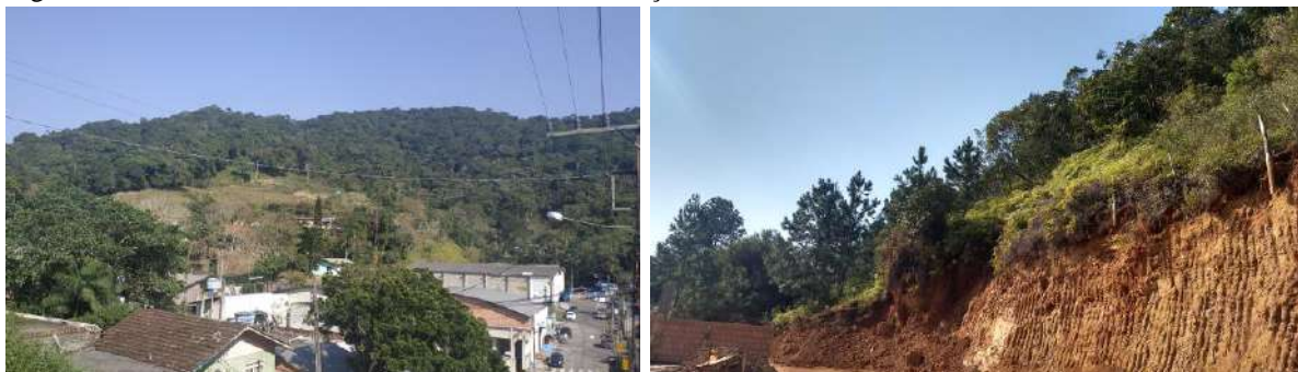
Figura 233 – Desmatamento das encostas no Bairro Nações.
