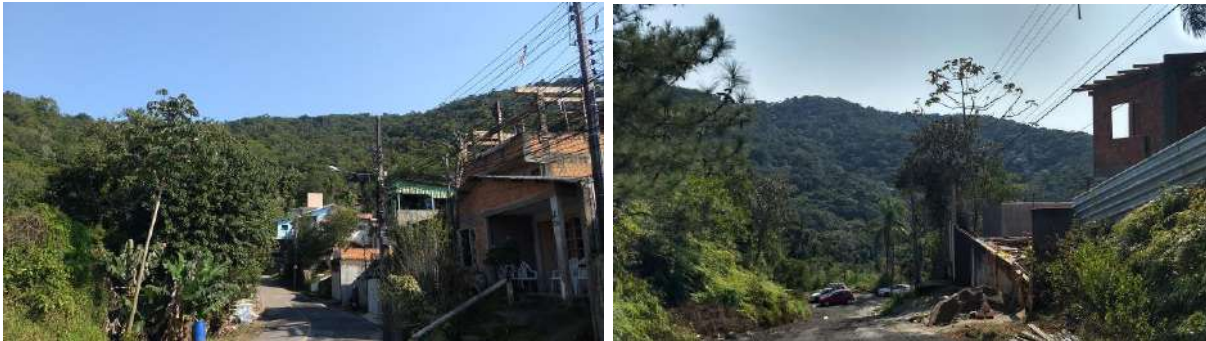
Figura 231 - - Exemplo de ocupação em encosta na Rua Mauritânia e Rua Zimbabue.
