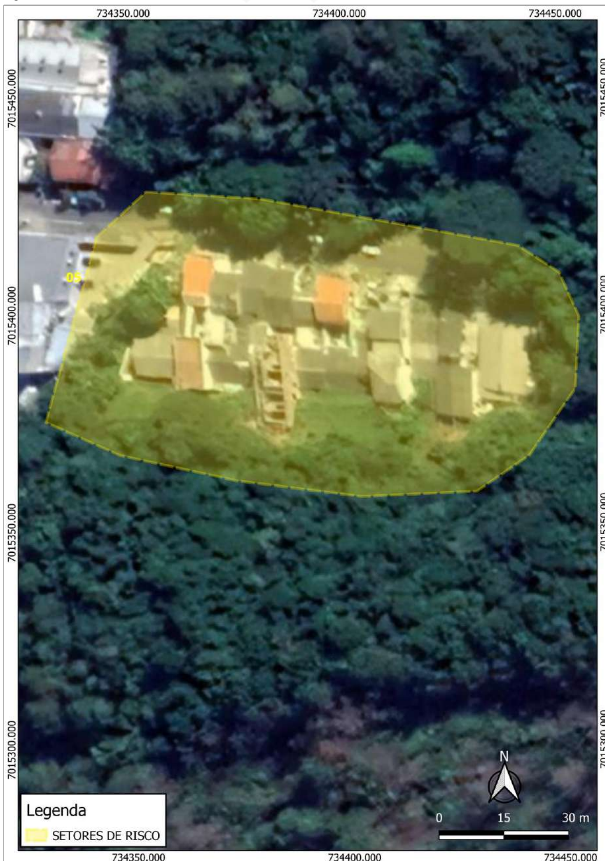
Figura 30 -Movimentos de Massa: Setor de Risco 05.
