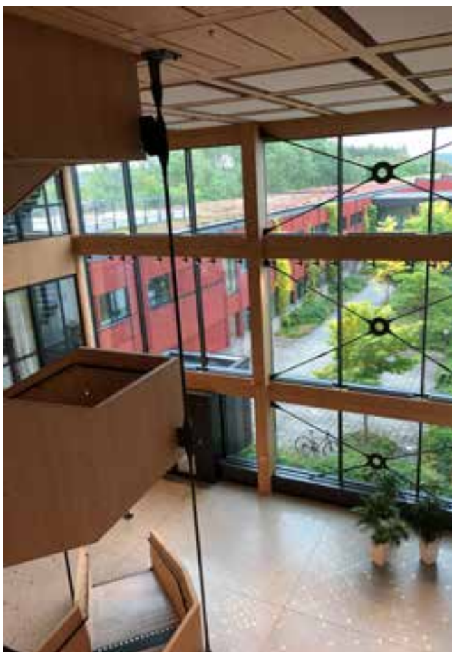
De äldre byggnadsdelarna av Ulls hus har moderniserats och även kompletterats med nya byggnadsvolymer.
