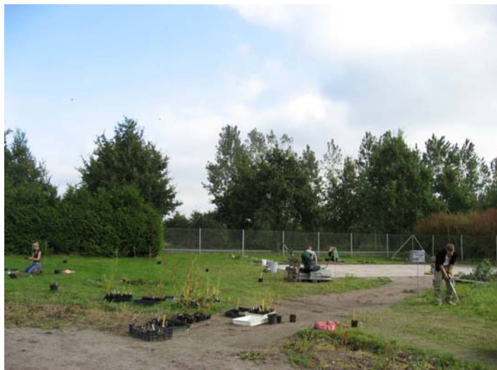
Figur 11. Plattläggning och plantering av östra delen.
