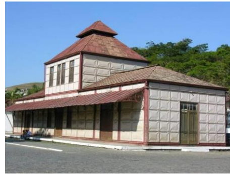
Estação Ferroviária. Fonte: Processo Condephaat
