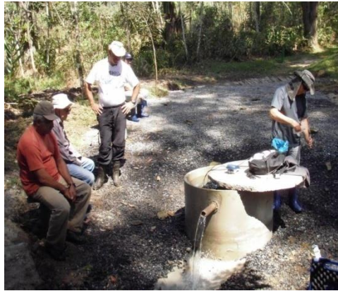
APÊNDICE 3.6.AR. Olho d'água protegido por cúpula de concreto (Fonte Roquete Pinto).
