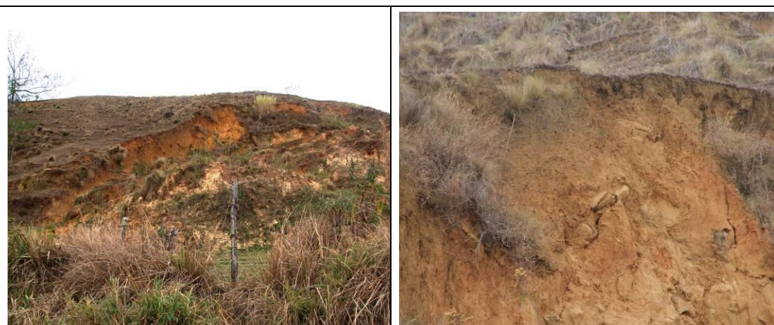
Fotos 57 e 58—Ocorrência de escorregamentos e processos de erosão laminar e em sulco freqüentes e de média a alta intensidade e a presença de depósitos constituídos por blocos e fragmentos de rocha em matriz argilo arenosa rica em grânulos de quartzo, são as características que conferem aos Terrenos Detríticos Colúviais Sensibilidade Geoambiental - Muito Alta.
