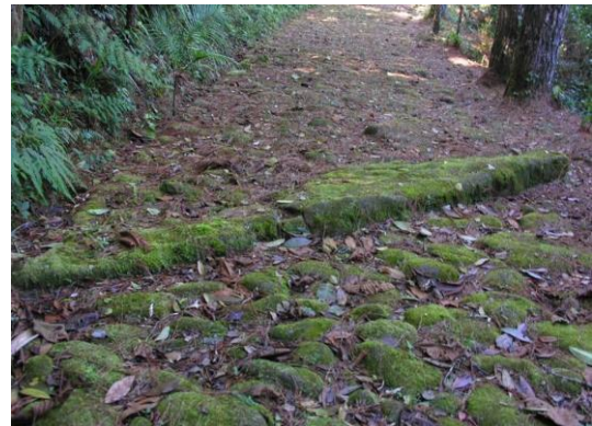
APÊNDICE 4.1.G. Canaletas de escoamento de águas pluviais
