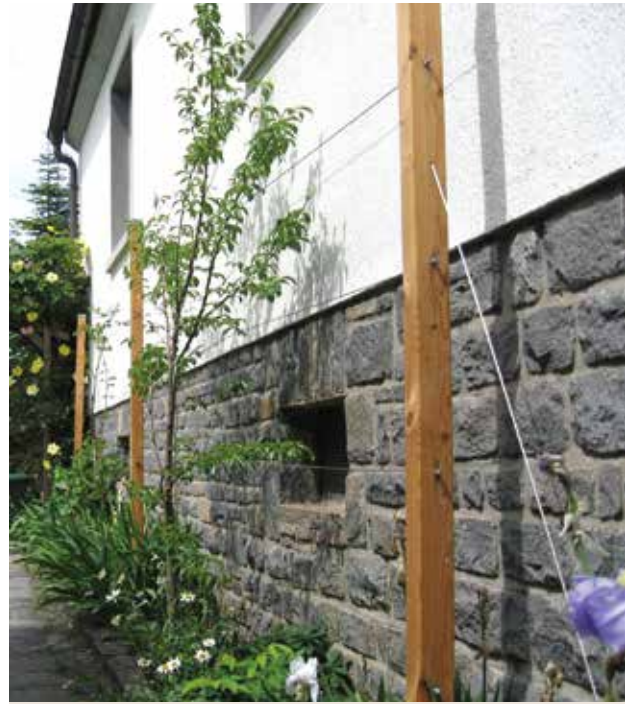
Drahtseilspalier für Pfirsich und Marille/Aprikose (Foto: Firma Fassadengrün)
