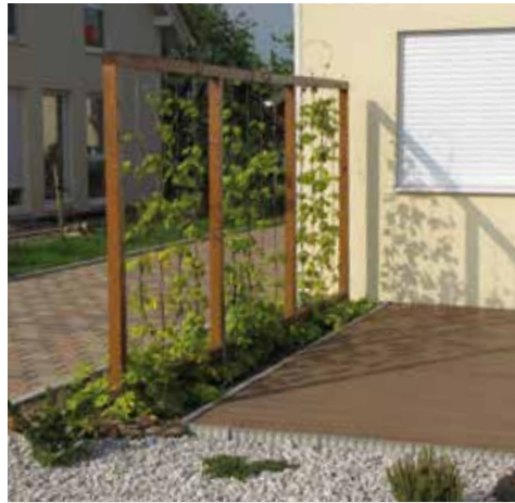
Rankrahmen mit U-förmigen Drahtseilen (Foto: Firma Fassadengrün)
