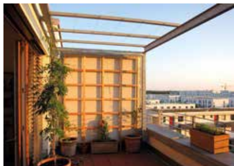
Mit Stahlseilen und Klemmrings bespannte Pergola auf einem Dachgarten (Foto: Firma Fassadengrün)
