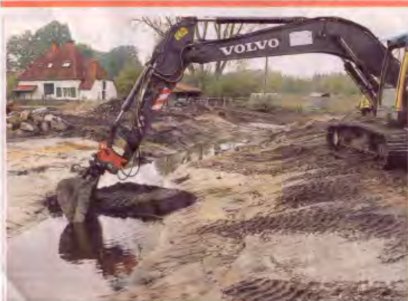
Schlüsse auf: Mit einem Bagger wurde der letzte Dünen beseitigt, dann strömte gestern das Wasser ins neue Bett des restaurierten Reiherbaches. Der Weg, der von dem Gebäude im Hintergrund herführt, wird von dem Bach durchschnitten. Dort wurde eine künstliche Furt angelegt.
