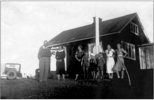
Juuri valmistunut Huvila 1930-luvulla. Oikealla näkyy osa lasikuistista. KUVA: ANNALAN KARTANO OY.
