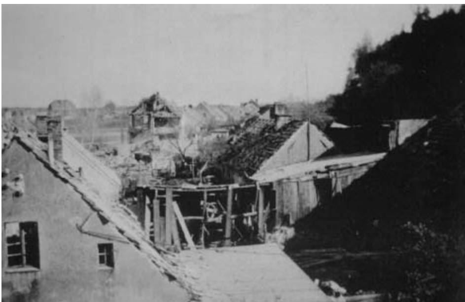
Bombenschäden auch in der Bergholzer Ravensbergstraße
