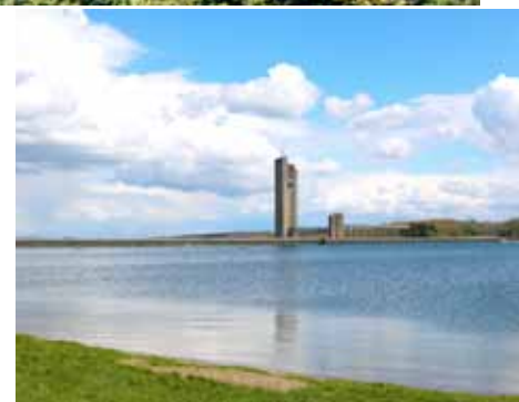
Zicht op de panoramatoren en de passerelle.
