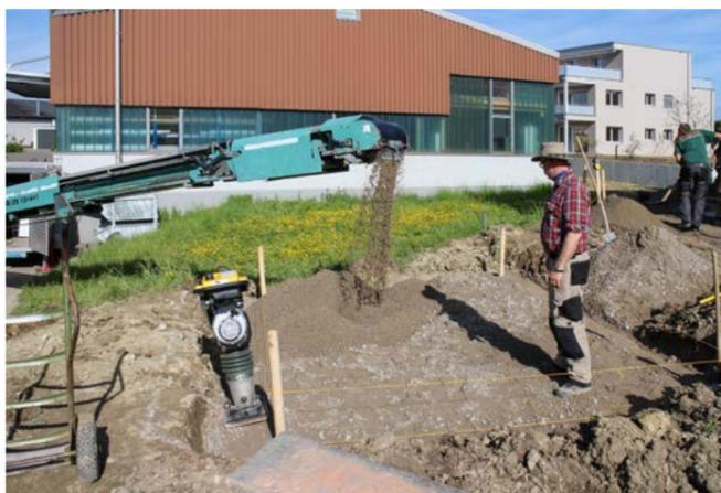
Einbau Fundamentsschicht mit Förderband
