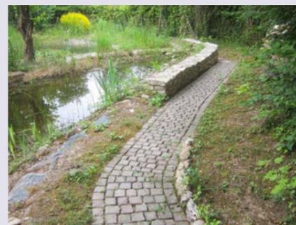
**Randefassung** – Flächenränder können unterschiedlich befestigt sein. In diesem Fall auf der rechten Seite des Wegs mittels regionaler Bruchsteine, auf der linken Seite durch die Läuferreihe aus dem verwendeten Basalt-Großsteinpflaster auf Betonbettung.
