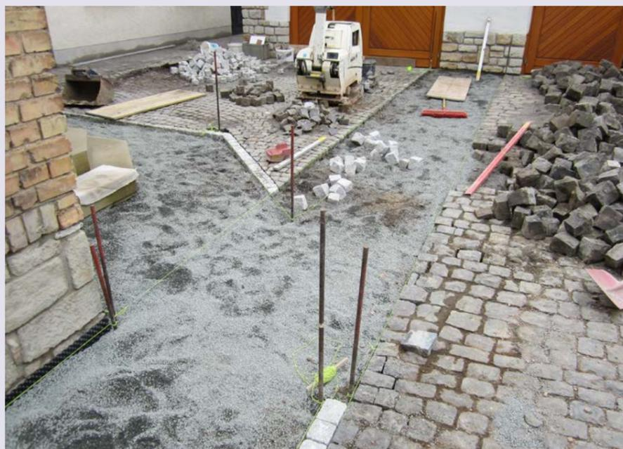
**Schnurgerüst** – Eine saubere Absteckung der Flächen erleichtert die Arbeiten und ergibt eine genaue Höhen- und Linienführung.
