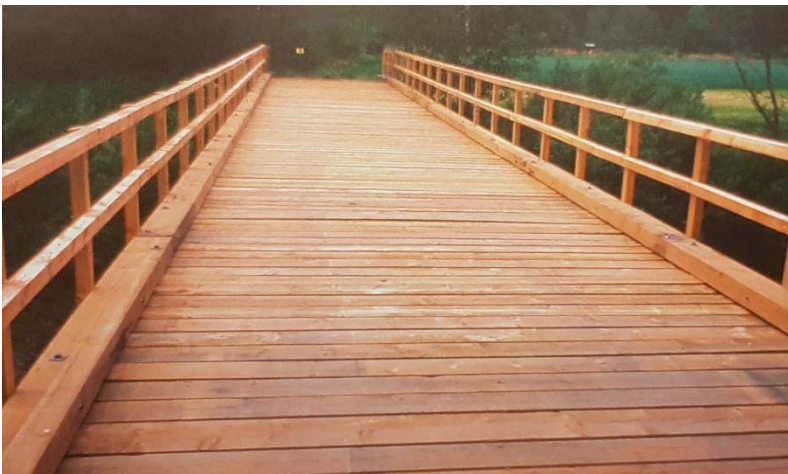
Abb. 11: Brücke in Pottenstein aus Schwarzkiefernholz. Foto aus Kohlross et al. (2006): „Die Schwarzföhre in Österreich“.
