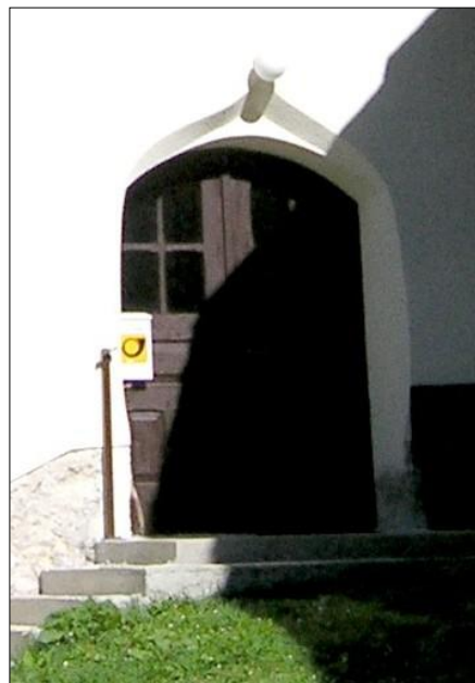
Vhodni portal v obliki oslovskega hrbta. Kropivnikova domačija. Foto: Saša Roškar, Arhiv ZVKDS OE Kranj.
