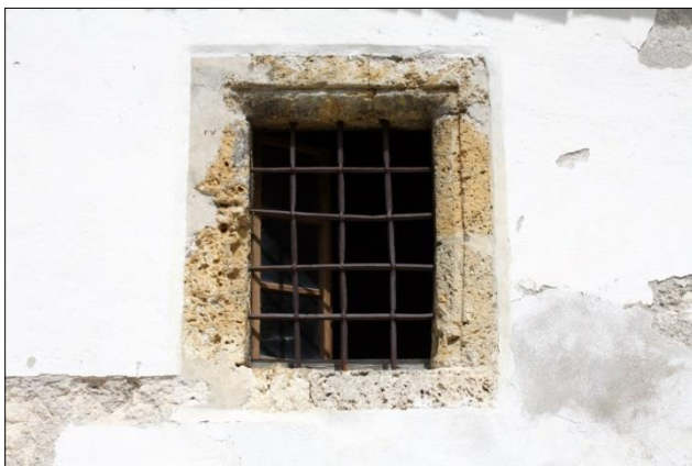
Kamnit okenski okvir posnet na ajdovo zrno s kovano mrežo. Šenkova hiša. Foto: Saša Rožkar, ZVKDS OE Kranj.
