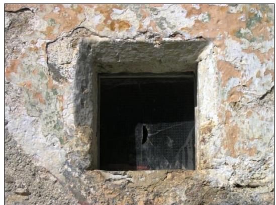
Manjše okno z kamnitim okenskim okvirjem posnetim na ajdovo zrno. Karničarjeva hiša. Foto: Saša Rožkar, Arhiv ZVKDS OE Kranj.
