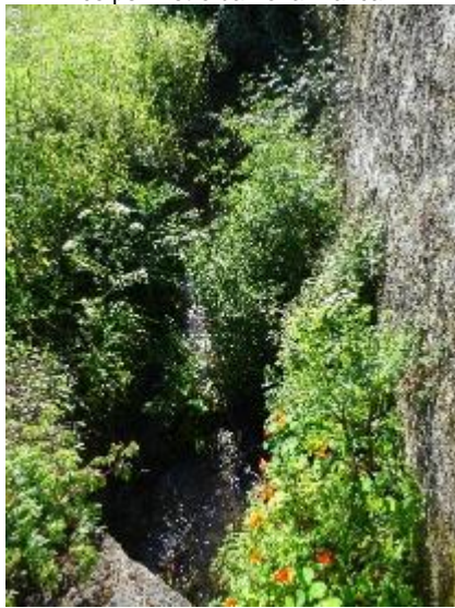
Canalización do rego no extremo oriental do ámbito que perdeu o bosque de ribeira polos muros das vivendas próximas á chaira aluvial
