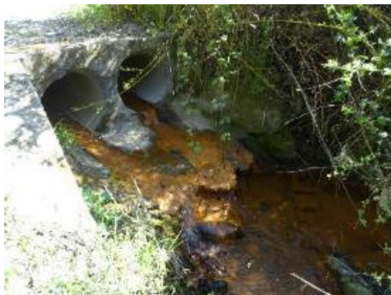
Desauges na área industrial con efectos contaminantes no medio.
