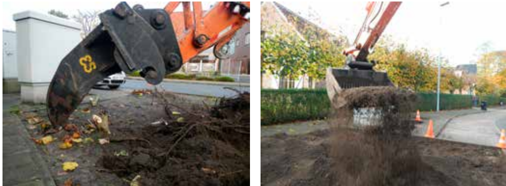
Figuur III.3 – Bij de heraanleg van dit plantvak werden de aanwezige heesters en boompjes afgezaagd. Daarna werd met een kraan met rippertand de bodem doorsgesneden. Zo werden niet alleen de wortels losgemaakt, maar werd ook de bovenste, verdichte laag weer losgewerkt. Vervolgens werd de toplaag uitgeschud met een zeefbak om resterende wortels te verwijderen. Het verwijderen van de bestaande beplanting werd dus gecombineerd met een bodembewerking om de verdichte toplaag te doorbreken en het aanslaan en het vlot doorgroeien van het nieuwe plantmateriaal te bevorderen. Bij dergelijke diepe groundbewerkingen is het best om voor de aanplant de grond tijd te geven 'zich te zetten', om het latere inklinken van de bodem en het verzakken van de beplanting te vermijden (foto's: Kris Vande Capelle, Gemeente Destelbergen).
