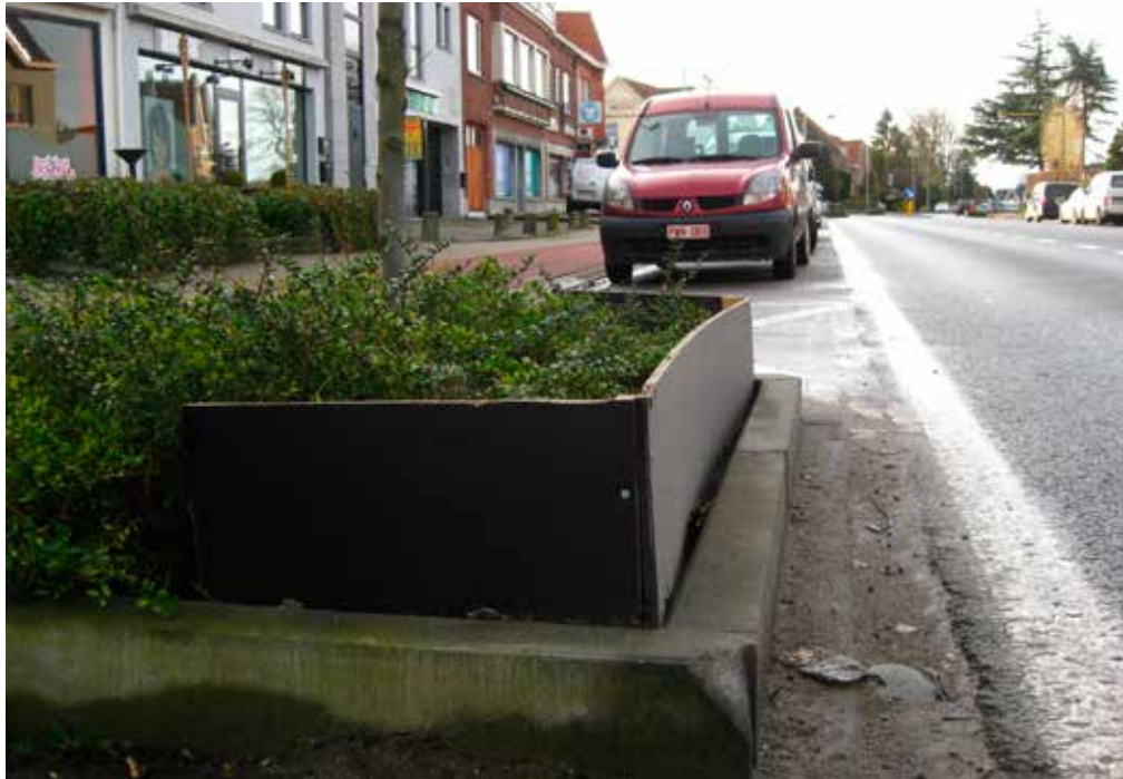
Figuur III.4 – Hier worden elke winter opnieuw deze afscherpende constructies geplaatst om zo de wegbeplanting te vrijwaren van spatzout. Dit is een goede oplossing, maar wordt het best gezien als een tijdelijke maatregel. Een meer betrouwbare en duurzame oplossing is een goed ontwerp van groenvoorzieningen in de verkeersruimte (en dus eigenlijk een integraal ontwerp van die verkeersruimte, met groenvoorzieningen niet als restruimtes, maar als volwaardige onderdelen met alle benodigde randvoorwaarden voor duurzame plantengroei) (Hundelgemsesteenweg, Merelbeke).
