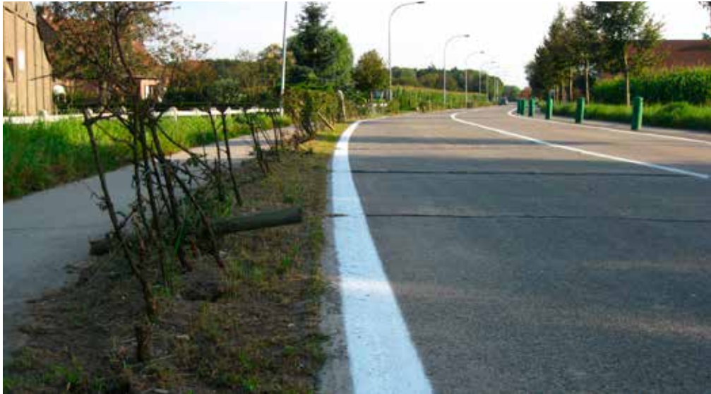
Figuur II.86 – Door een extreme standplaats (zoals invloed van strooizout, te nabije invloed van verkeer, beperkte doorwortelbare ruimte en beperkte bovengrondse ruimte) is een geschoren haag als groenvorm niet te realiseren op deze plaats (Zomergem).
