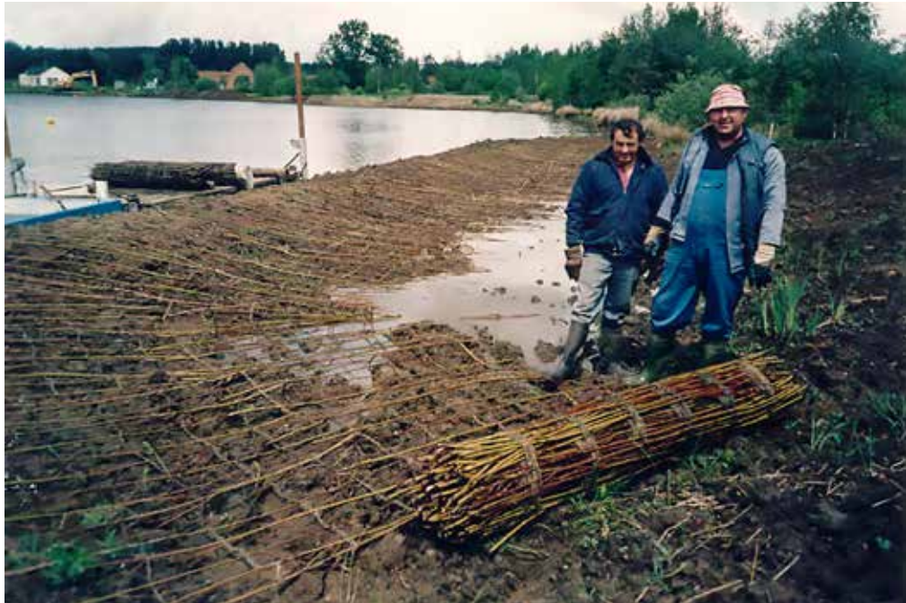
Figuur II.34 – Aanleg van Salix -matten (die mogen doorschieten) in een te draineren terrein (grond bestond uit baggerspecie), om zo de bodem vast te houden en te ontwateren. Na een jaar waren de wilgen voldoende volgroeid om deze functie te vervullen (foto: De Vos Salix).
