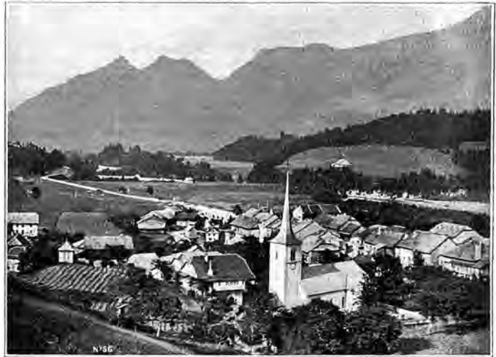
Neirivue avant l'incendie de 1904, vu du Sud-Ouest.
