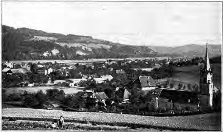
Oberburg, vu du Nord-Ouest.
