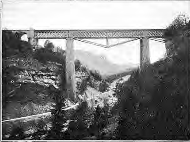
Pont de la ligne Vallorbe-Pontarlier.
