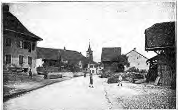
Vue prise à Ogens.
