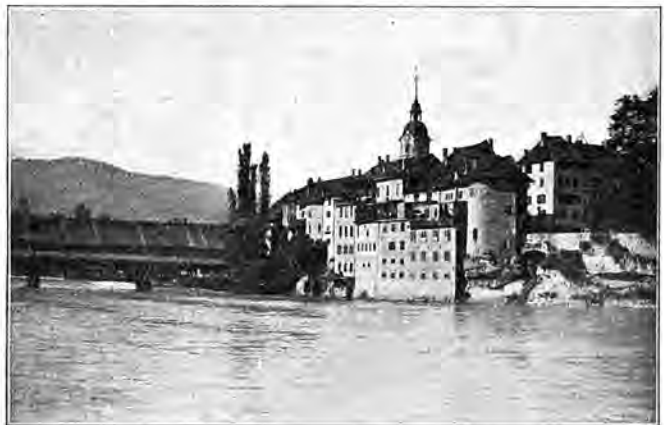
Olten. Le vieux pont de bois et le château.
