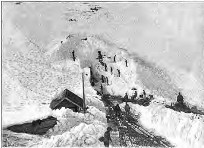
Les Rochers de Naye. La ligne de Glion-Naye à l'époque du déblaiement des neiges.
