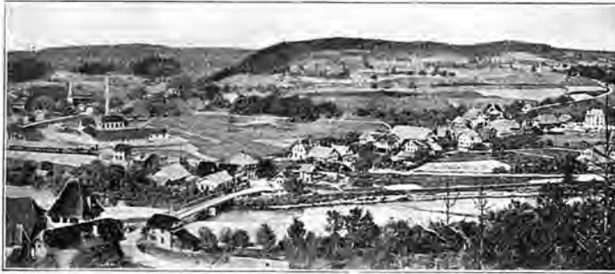
Neuenegg, vu du Sud.
