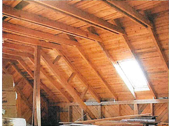
Abb. 12: Dachstuhl aus Schwarzkiefernholz. Foto aus Kohlross et al. (2006): "Die Schwarzföhre in Österreich".
