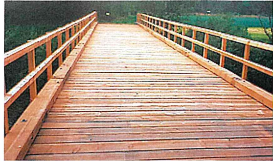
Abb. 11: Brücke in Pottenstein aus Schwarzkiefernholz. Foto aus Kohlross et al. (2006): "Die Schwarzföhre in Österreich".
