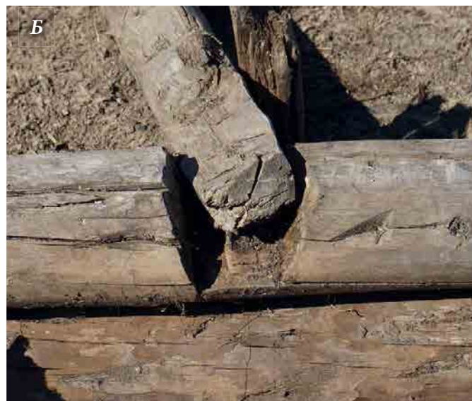
Рис. 17. Постройка 22. Срубная постройка в технике «в обло» с остатком и с нарами у юго-западной стены. А – общий вид. Б – паз, вырубленный в стене постройки для фиксации конца лаги, на которую укладывался настил нары
