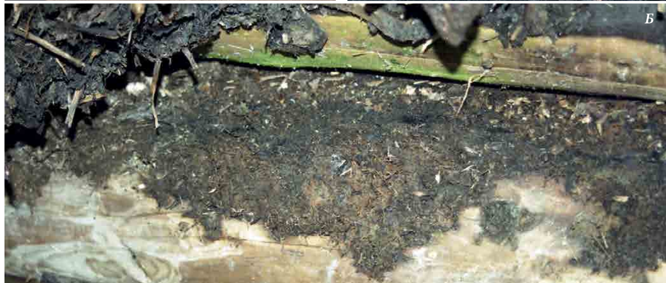
Рис. 18. Постройка 22. А – Постройка с глинобитным полом с печью-каменкой в северном углу и нарами у юго-западной стены. Б – Паз, вырубленный в стене постройки для фиксации конца лаги, на которую укладывался настил нары
