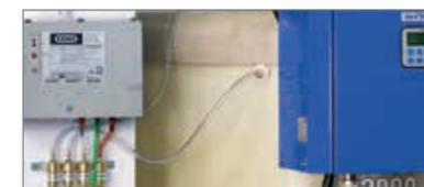
CEMO DWT-Tanks, doppelwandig, mit Leckanzeigergerät.
