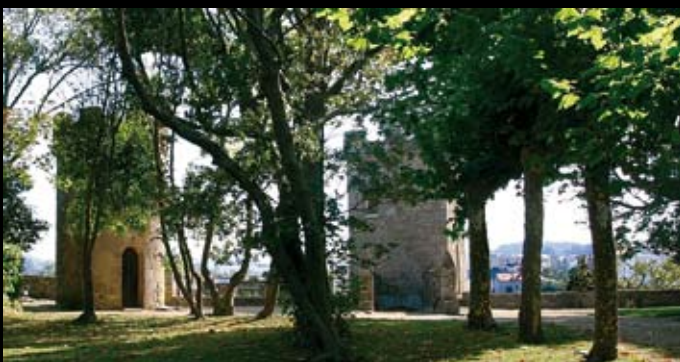
Foto 4. Conservación de la vegetación arbórea, eliminación de elementos distorsionantes y explanación del terreno en la zona intramuros.
