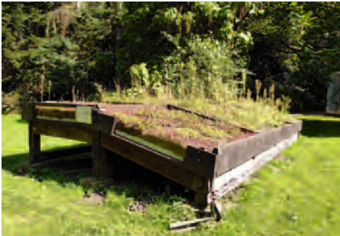
Das dackelbeinige Grasdach
