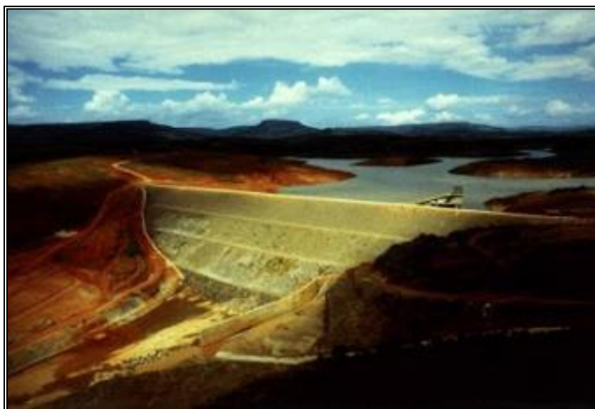
Figura 8.7 – Barragem do Calhauzinho
