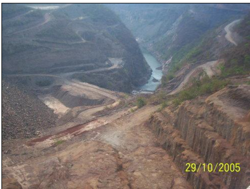
Figura 6.9 – Foto Construção da barragem de Irapé (Foto: Vinicius Queiroga)
