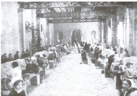
La technique de l'enflourage, aujourd'hui tombée en désuétude, fit la renommée de Grasse au XVIII e siècle. Ce procédé consistait à recouvrir d'un mélange de graisse de porc et de bœuf des plaques de verre de 50 à 60 cm de côté insérées dans des cales en bois, le tout constituant des châssis. 30 à 50g de fleurs fraîches étaient délicatement posés sur la graisse. On empaquetait alors ces châssis sur des tables par piles de 34. L'opération était renouvelée 30 ou 40 fois, jusqu'à saturation de la graisse qui était ensuite recueillie puis traitée. Ce procédé exigeait un nombre impressionnant de châssis - 80 000 dans les établissements Chiris.
