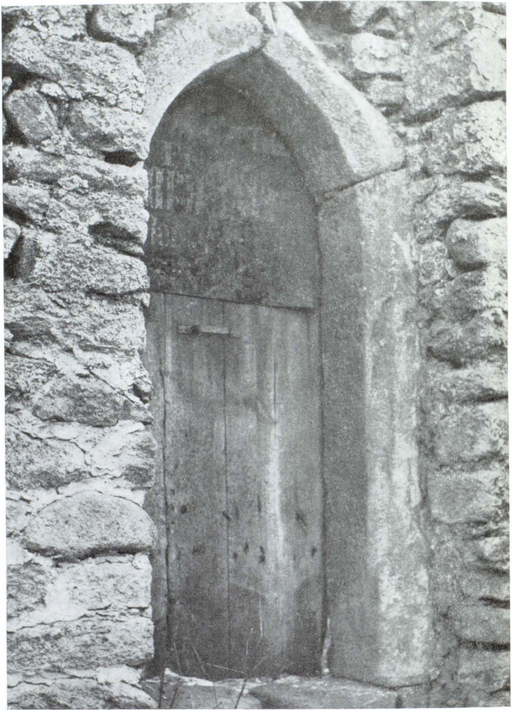
Alter Durchgang in der Litschauer Stadtmauer (Foto: Pígal, Litschau)
